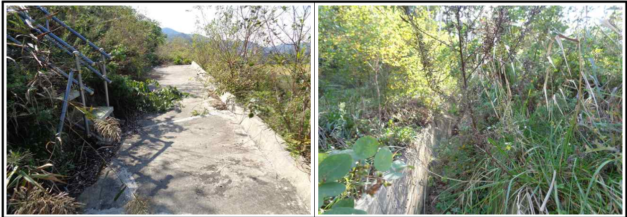
【그림 1.3.3】 배수시설 전경
