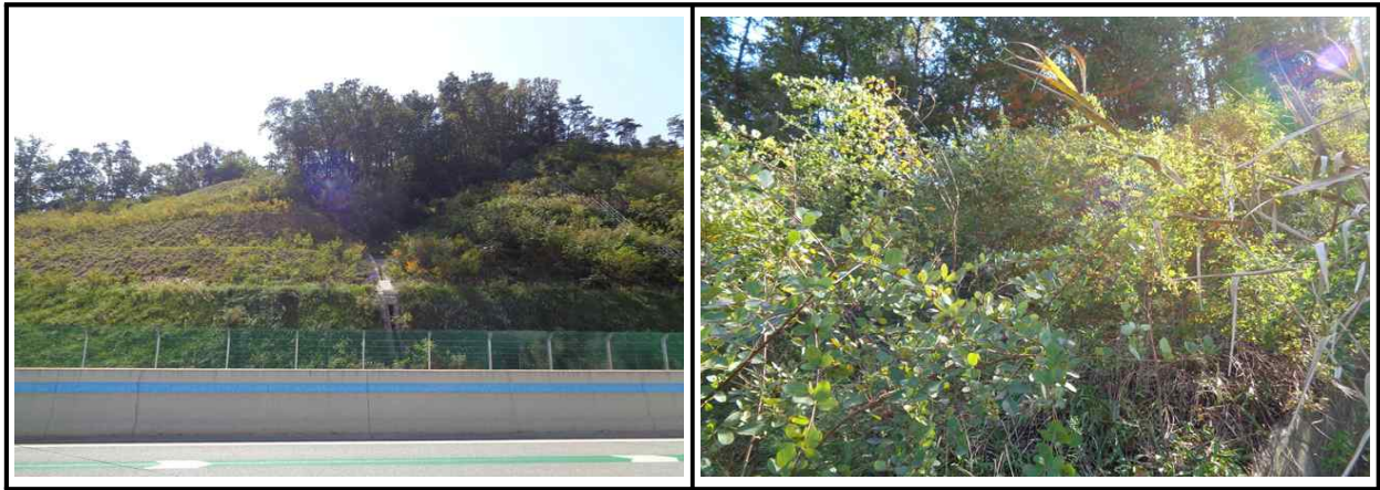
【그림 1.3.1】 상부자연사면 전경
